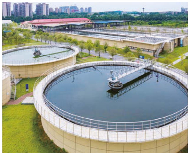
● 本行湖南省分行與長沙水業集團合作20餘年，為其累計發放近15億元貸款支持水源建設、污水處理等民生工程。圖為長沙水業集團水源建設及污水處理設備運行場景。
