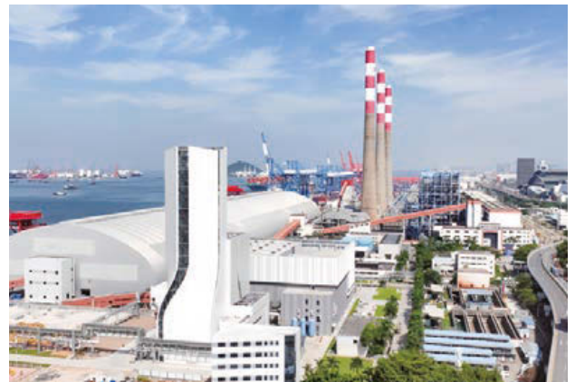
● 本行深圳市分行為媽灣電廠升級改造提供金融支持，圖為媽灣電廠升級改造氣電一期項目。
