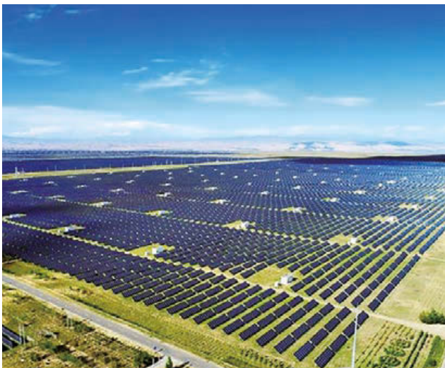
● 本行青海省分行為海南州清潔能源產業提供多元化綠色融資支持。圖為青海海南州塔拉灘生態光伏園。
